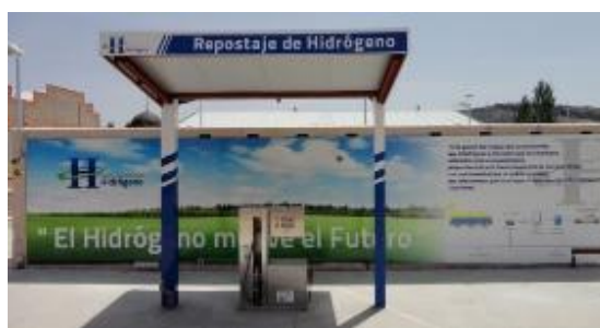
Imagen 27: Hidrogenera del CNH2
